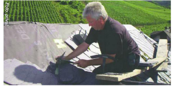
Altes neu ent- und eingedeckt: Christian Gietz fertigt eine Altdeutsche Schiefereindeckung in Senheim.
