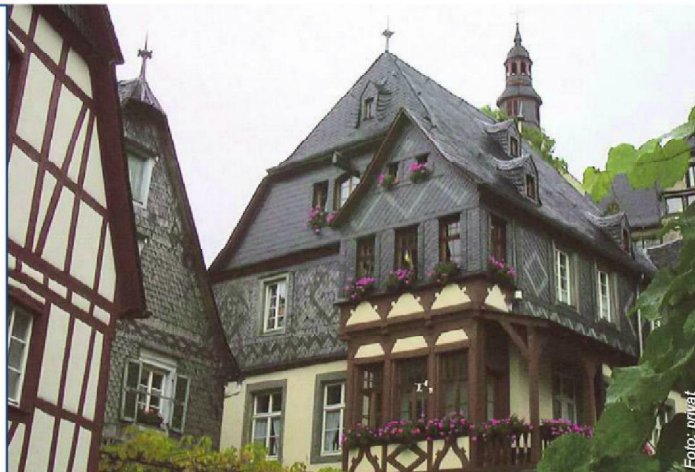
Kunstvolle Schiefer-Ornamenteindeckung bei einem alten Fachwerkhaus in Beilstein: Hier hat das Team um Dachdeckermeister Christian Gietz sein ganzes Können eingesetzt.
